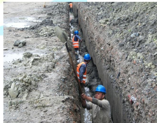
Zanja para instalación de tuberías PVC de pared estructural corrugada - Candelaria
