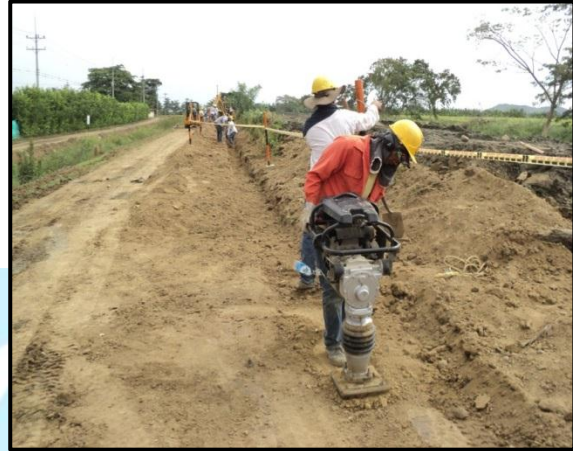
Relleno compactado posterior a la instalación de tubería PVC biorientada - Roldanillo
