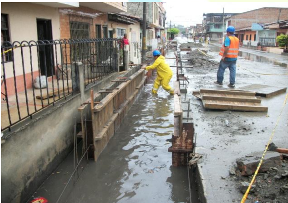
Canaleta para manejo de aguas lluvias - Candelaria
