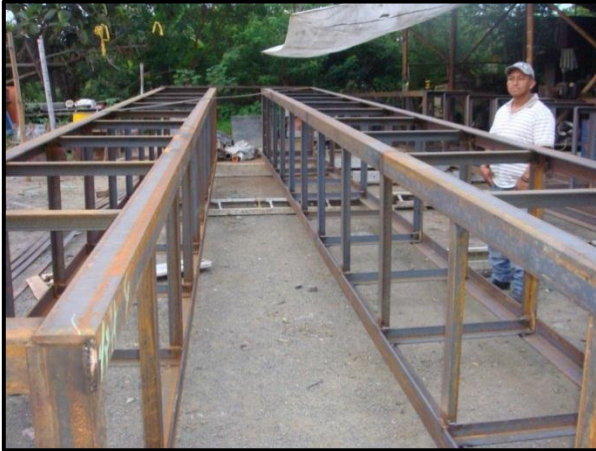
Viaducto para soportar tubería en paso por canal Administrado por ASORUT – Roldanillo
